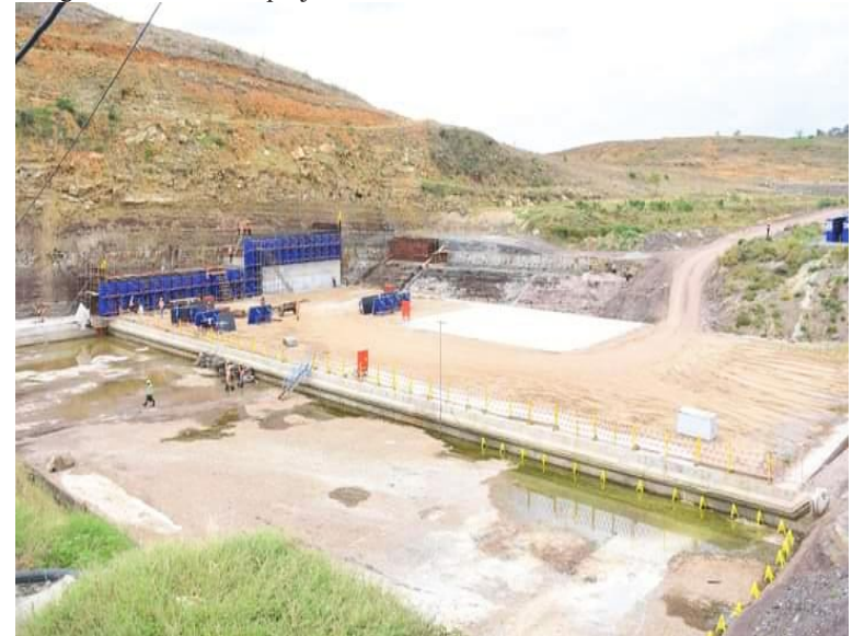
Mwache dam project
